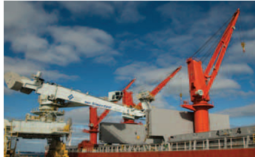
Figure 5.28: Siwertell unloaders, Kwinana Bulk Jetty
