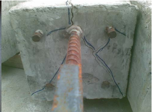
Fig. 3 (b) : OPC concrete specimen
