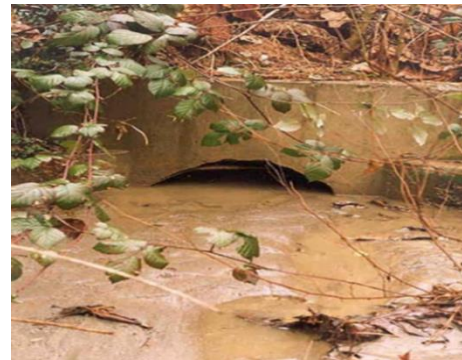
(d) Stormwater drainage blockage
